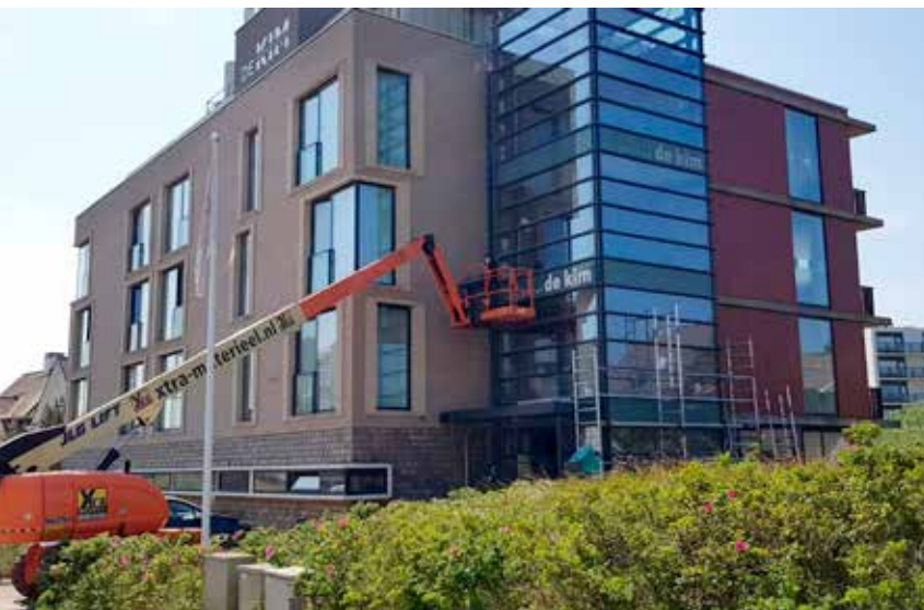
Project De Kim Noordwijk - Ook zijn alle kitranden vervangen en is de gevel gereinigd.
