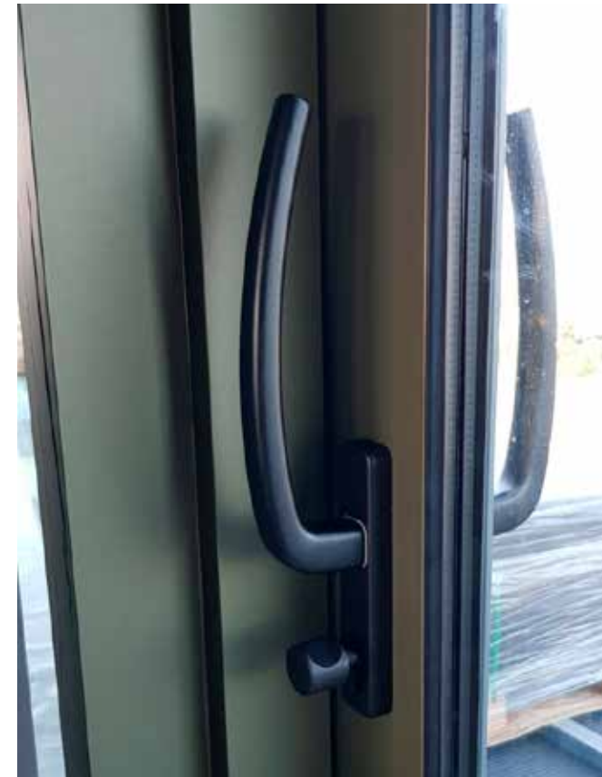
Penthouse Freek Vonk - De deurgrepen heeft Holland Geveltechniek laten moffelen bij de spuiterij in de kleur mat zwart.
