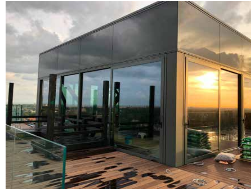
Alle aluminium schuifpuien (25 stuks) zijn voorzien van façadefolie van Avery Dennison in de kleur Midnight Sand Mat, deze kleur is speciaal door Avery geproduceerd voor dit project, op wens van de klant.
