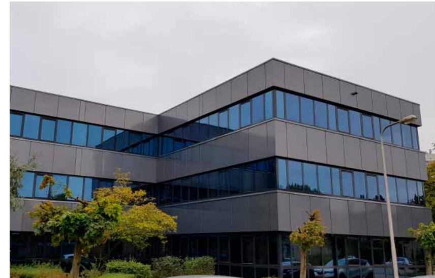
Kantoorgebouw te Ridderkerk voorzien van folie op de panelen en kozijnen.
