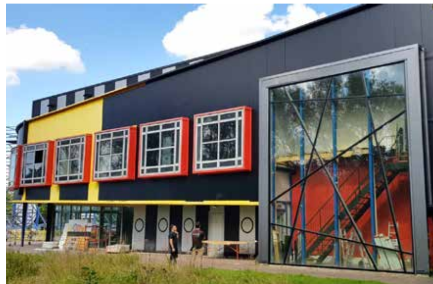
Bedrijfspannd te Roosendaal, de complete buiten gevel werd aangepakt. De gele panelen werden voorzien van mat zwarte folie, de rode delen werden voorzien van een metallic zilveren folie.
